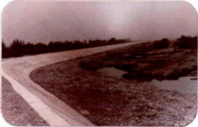
▽ 上色拉阿拉尔永久性防洪坝
