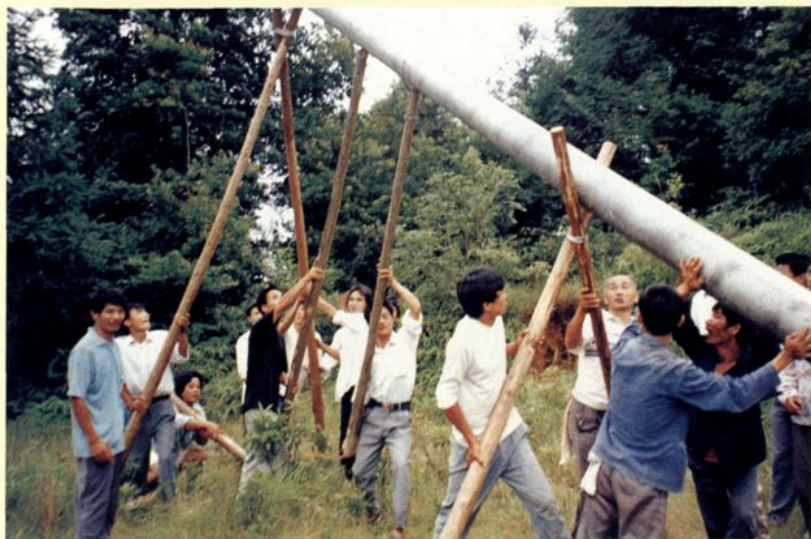
◀ 英德市农村电网建设与改造施工现场（1999年摄）
