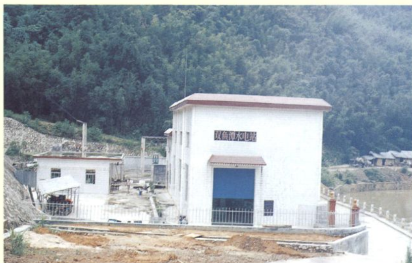
◀ 英德市双鱼潭水电站， 装机容量 2 \times 3200 千瓦 （2000年12月28日建成）
