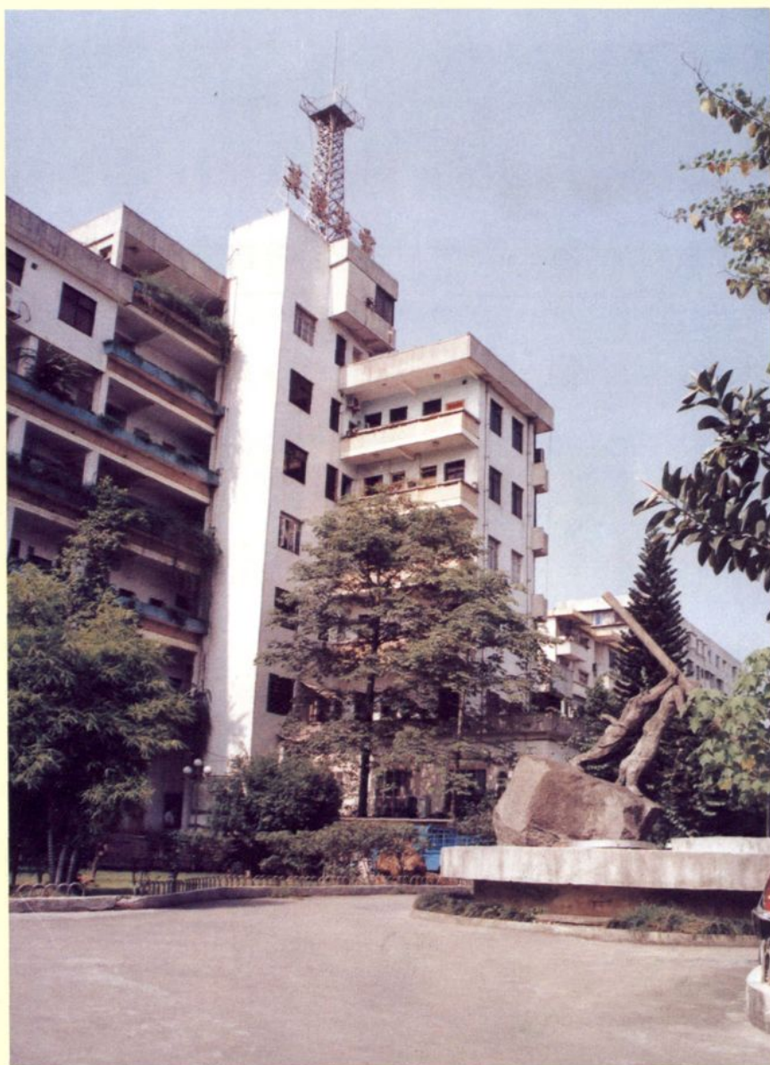
英德市供电局调度综合大楼（1987年建成）
