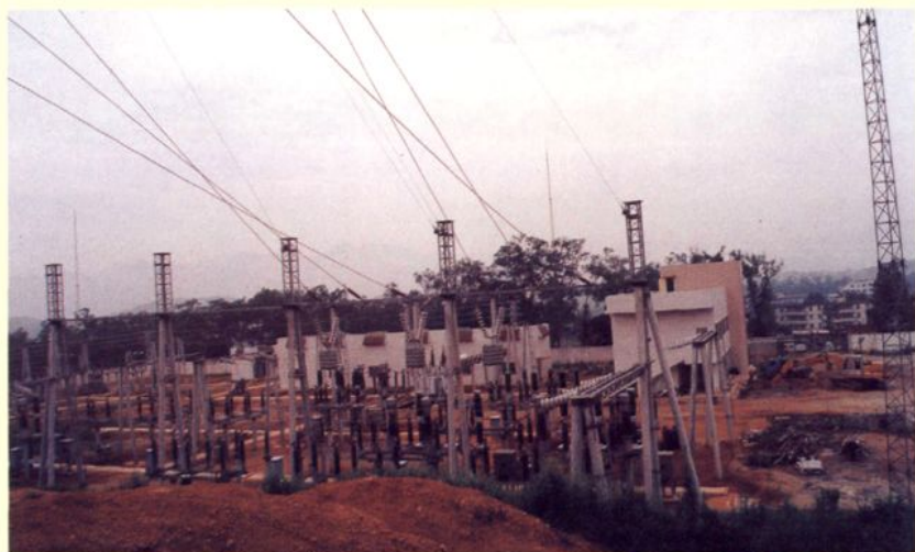
◀ 建设中的110千伏望埗变电站（2000年摄）
