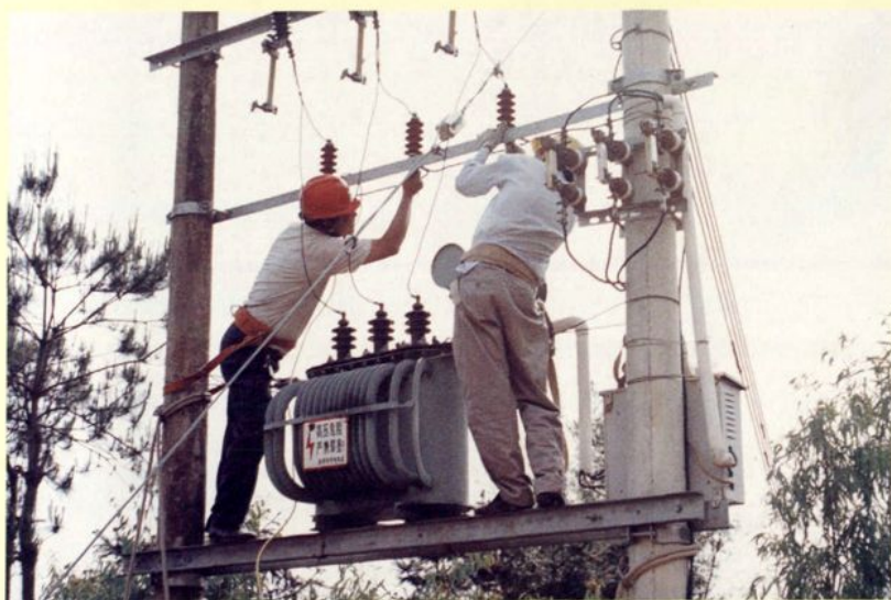
◀ 供电所员工检修农村电力设备现场（2000年9月）
