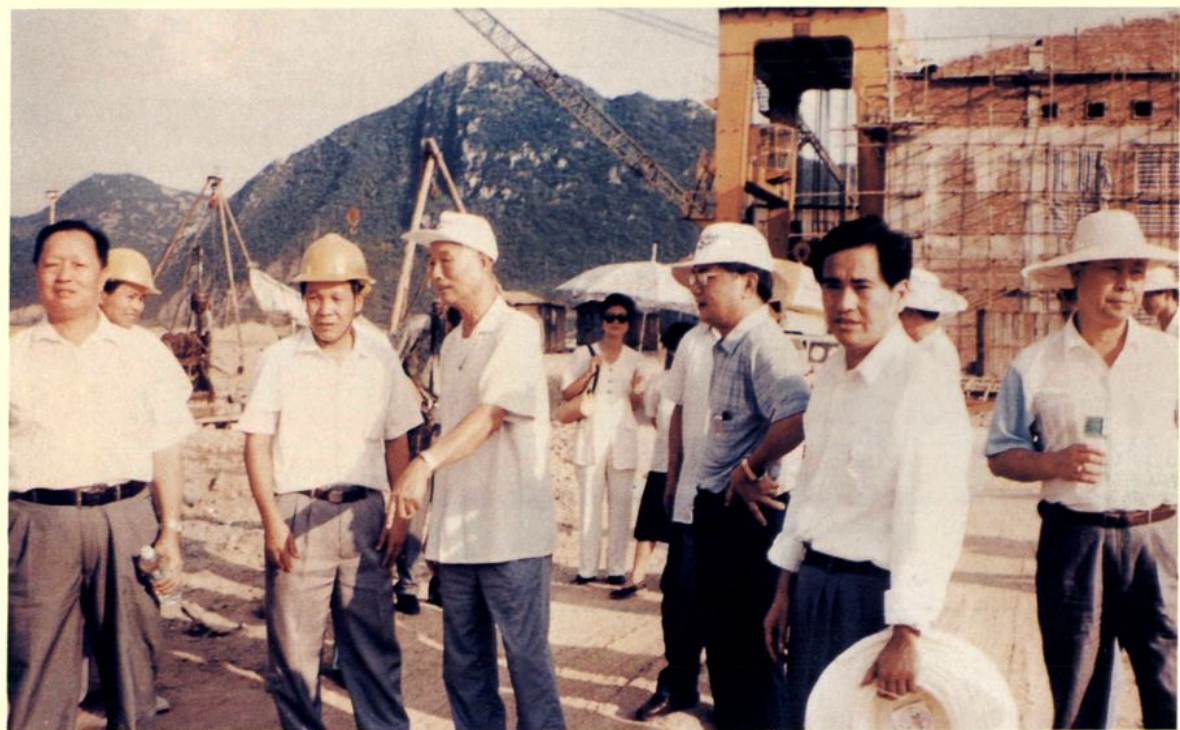
1996年9月18日，广东省省人大主任林若（左三）视察英德市白石窑水电厂建设工地
