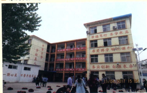
▲ 东院校区教学楼
