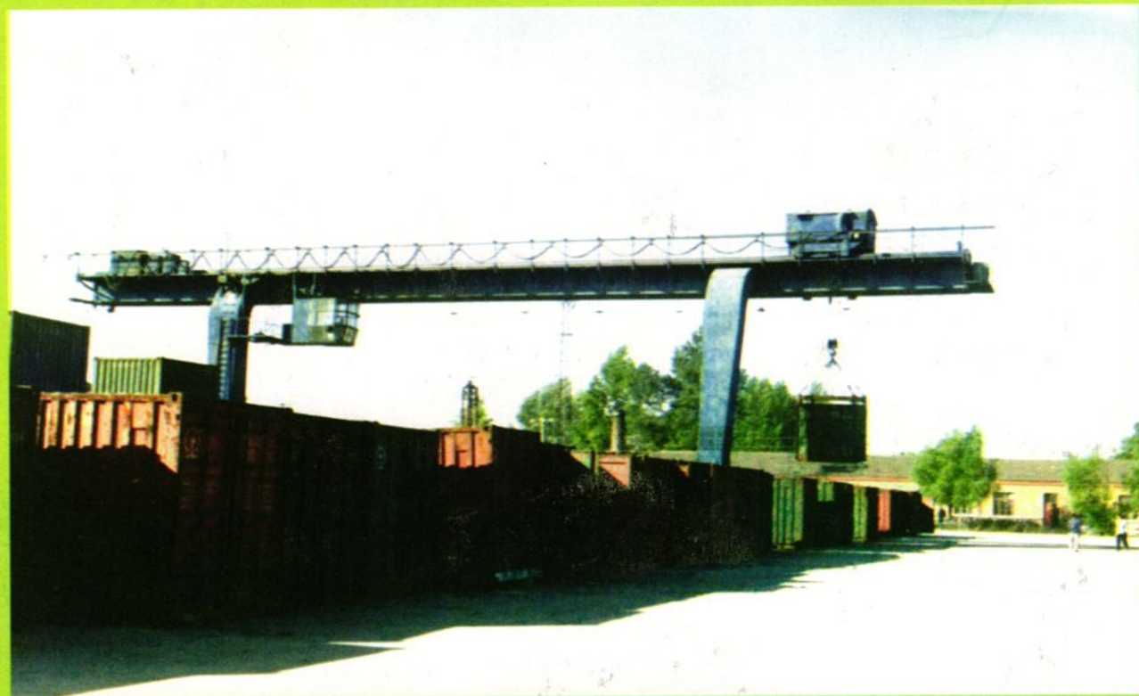
1988年建成的车站二货场集装箱站台
