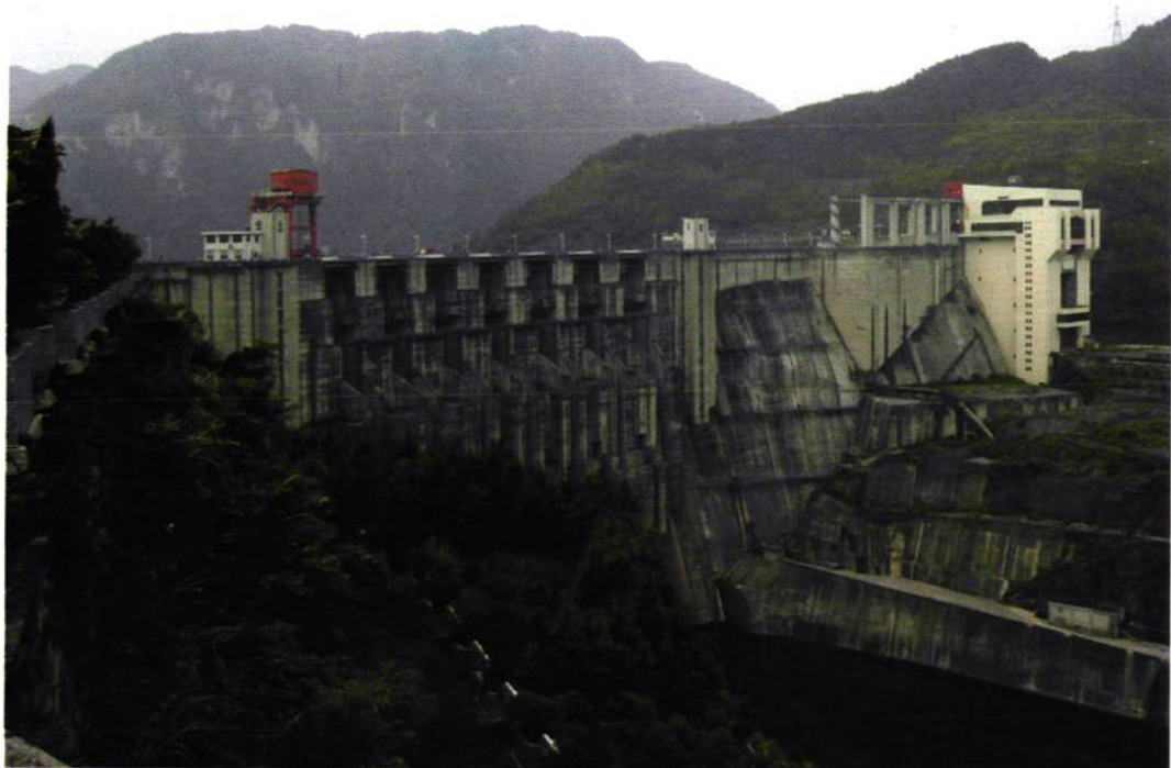
隔河岩大坝（邓守政摄）
