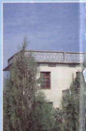
南干渠邹陂管理站
