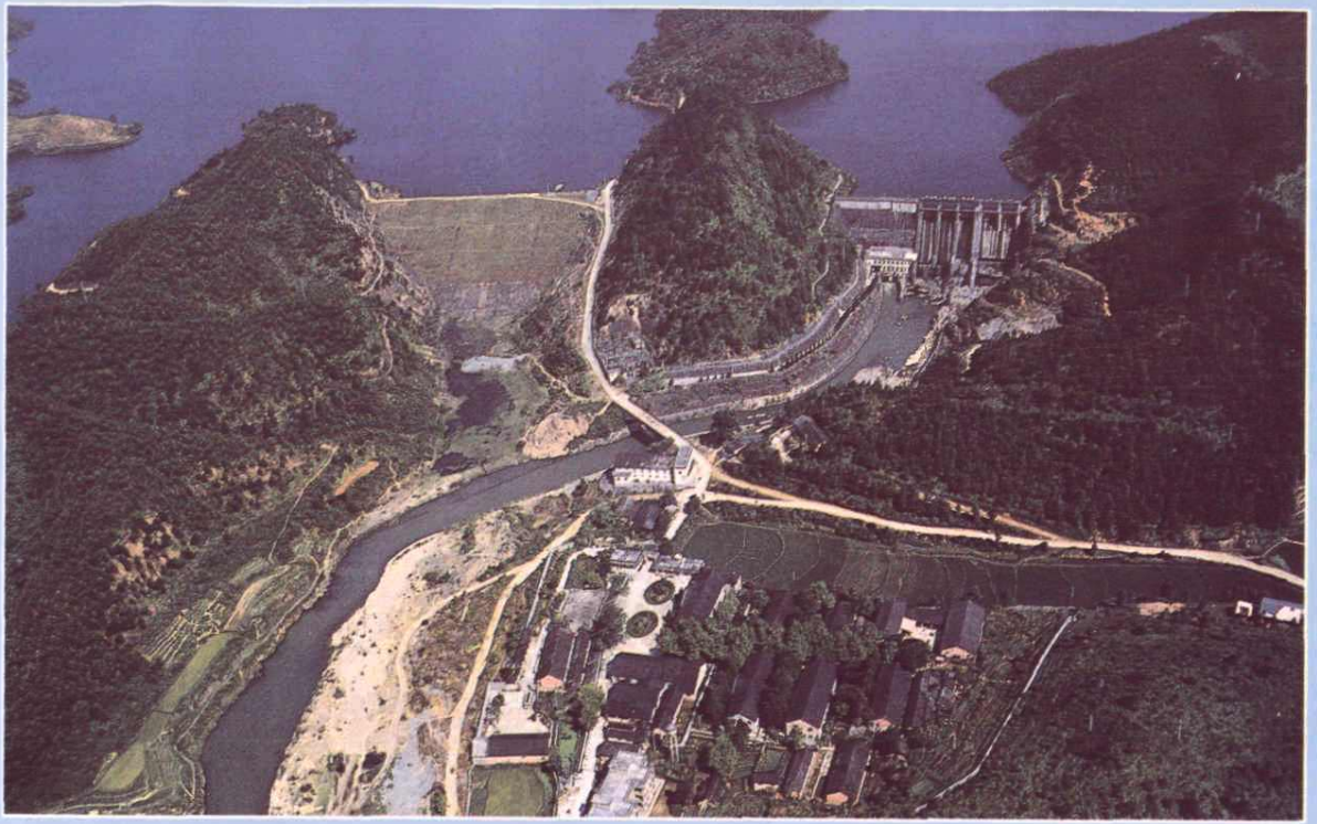
社上水库大坝、副坝、生活区
