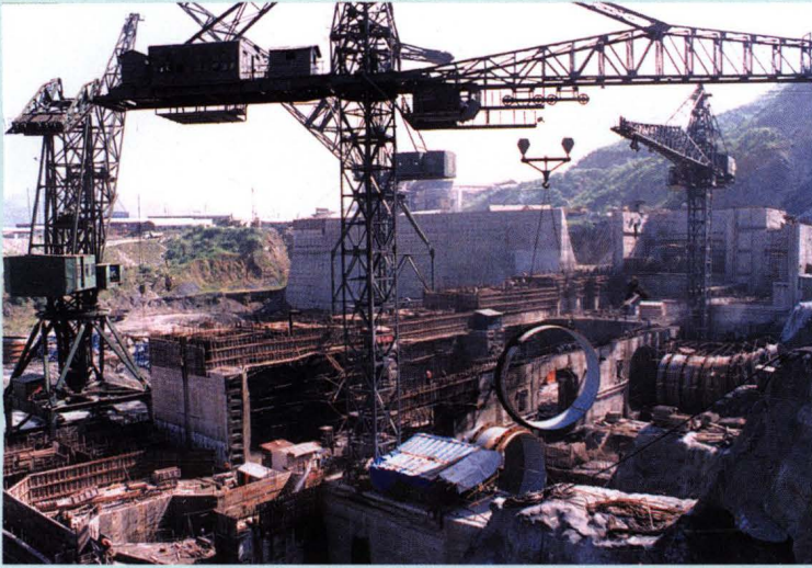
水电站厂房混凝土浇筑
