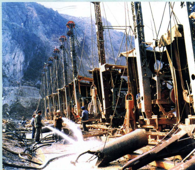
下游围堰防渗墙施工
