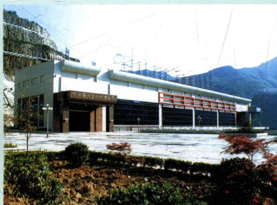
隔河岩水电站厂房外景
