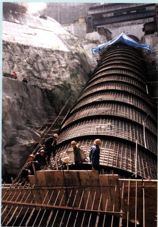
压力钢管安装
