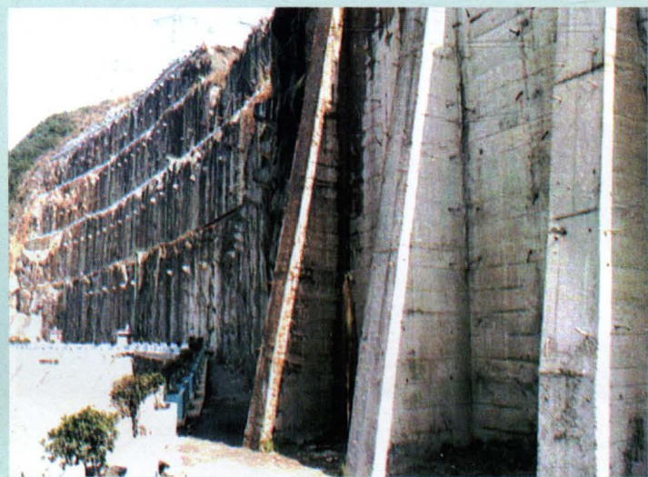
电站厂房及高边坡施工
