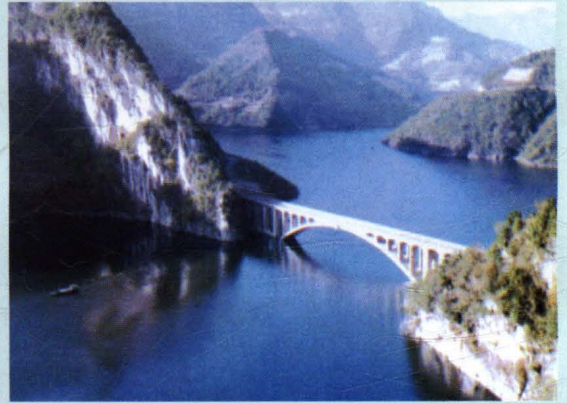
库区交通道路重建
