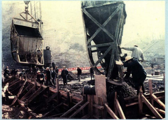
1988年12月13日大坝开始浇筑第一仓混凝土
