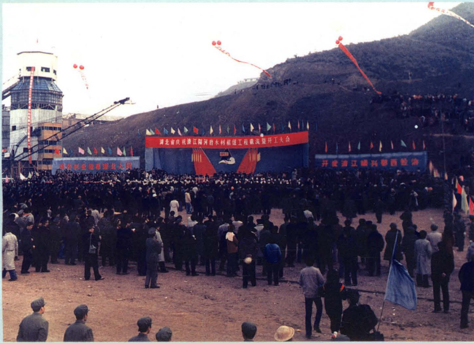
1987年12月5日隔河岩水电站工程截流暨开工
