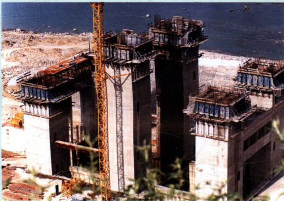
垂直升船机混凝土浇筑
