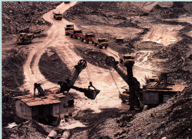
1988年1月1日大坝基坑开始开挖
