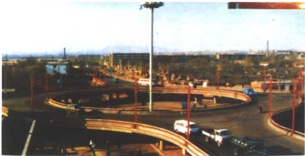
尖草坪立交桥
