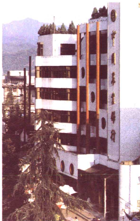
中國農業銀行建德市支行辦公樓
