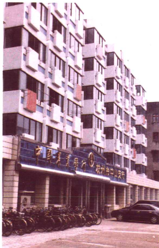
中國農業銀行杭州市中山支行辦公樓
