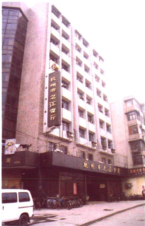
中國農業銀行杭州市之江支行辦公樓
