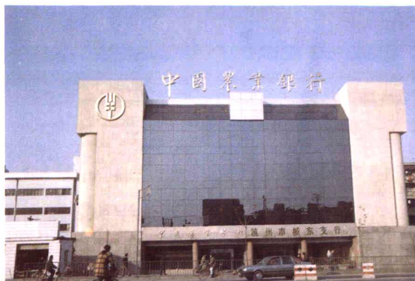
中國農業銀行杭州市 城東支行辦公樓
