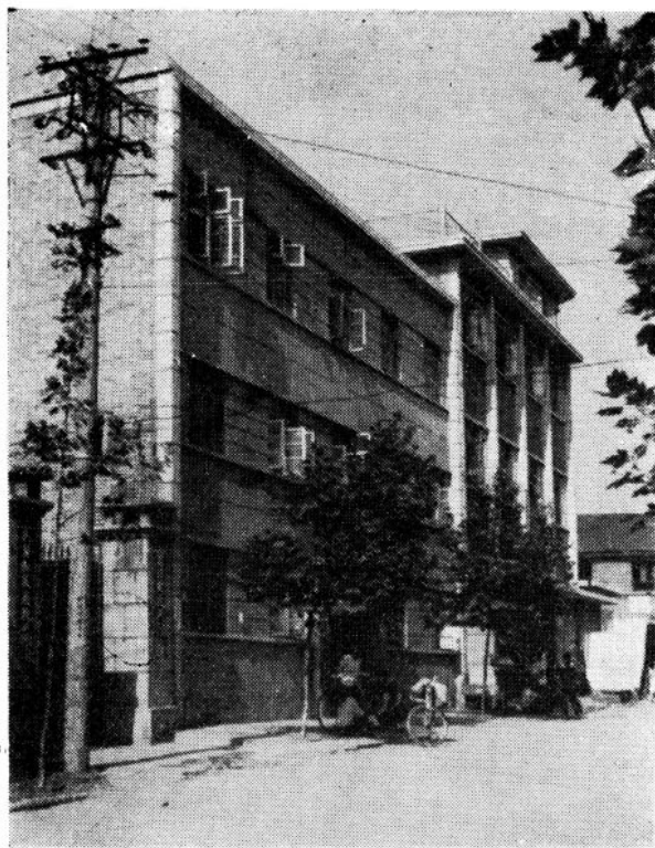
县社营业大楼 1977年建
