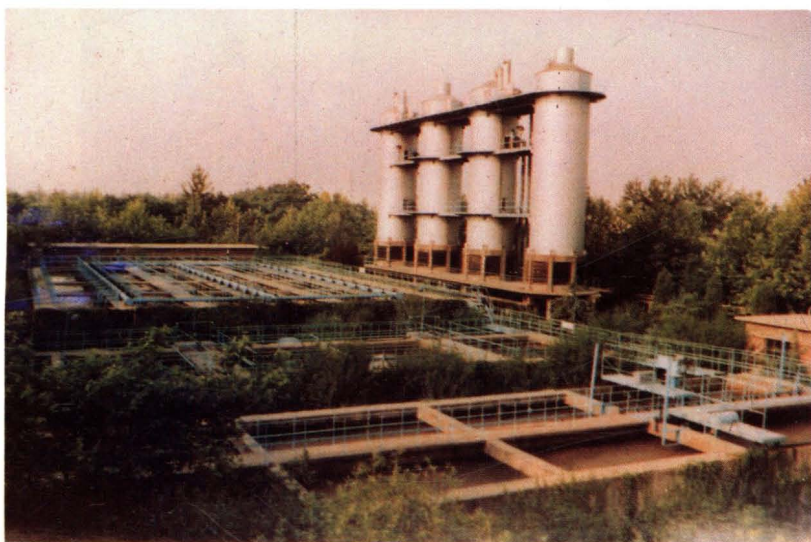
净化车间 第一胶片厂废水
