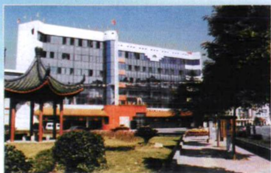
建设初期的管委会办公大楼
