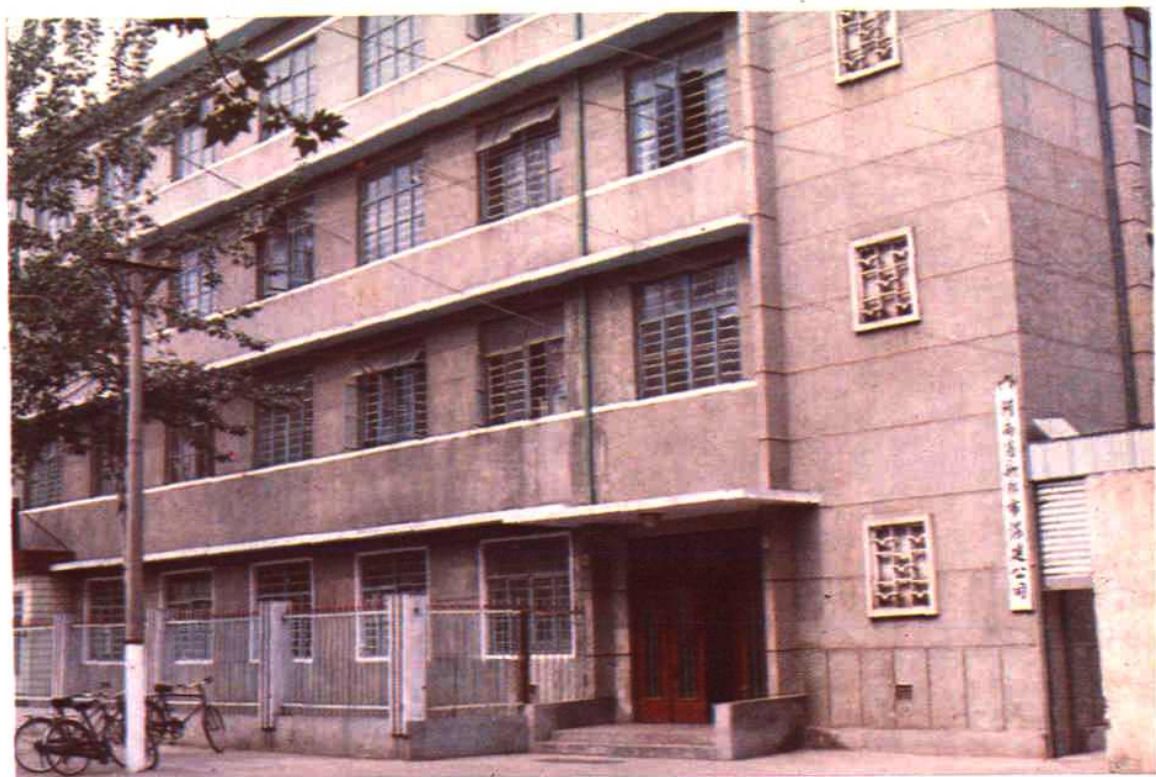
新乡地区煤建公司办公楼
