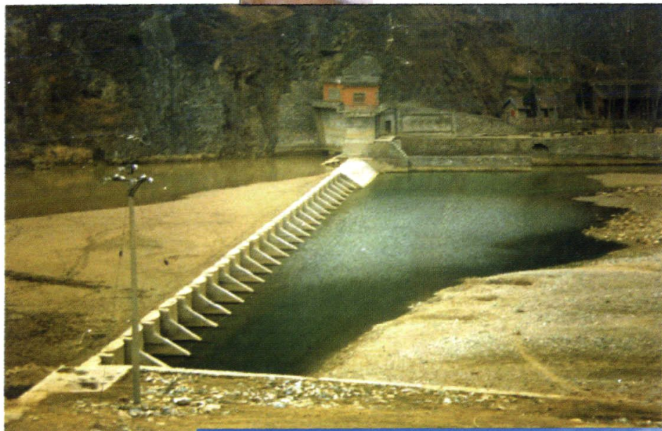
陕县涧里水库迷宫堰工程
