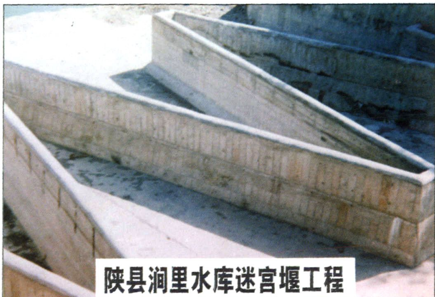
▶ 陕县涧里水库迷宫堰工程
