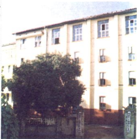
福建省宁德地区档案局、馆外景
