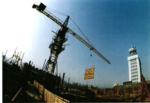
建設中的濟寧市工商銀行綜合樓
