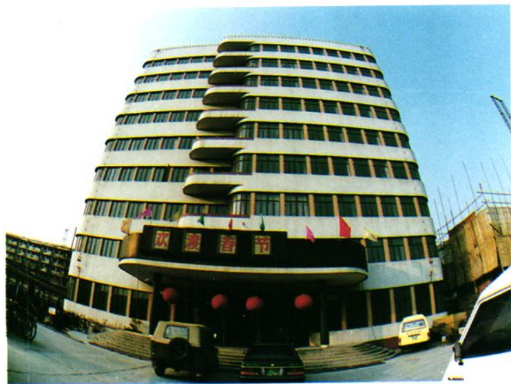
濟寧市外貿局辦公樓（1987年承建，省優質工程）
