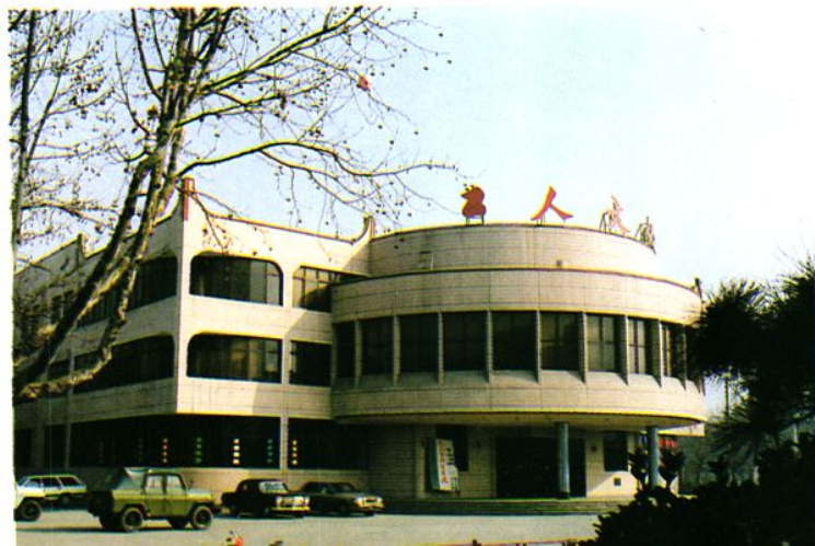
濟寧市工人文化宮（1990年承建，市銀牌工程）
