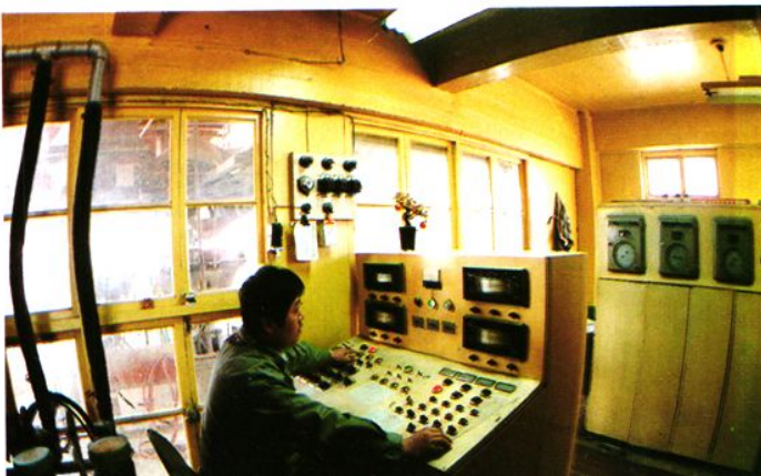
預製廠自動化攪拌電子操作室
