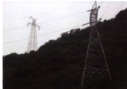
20万千伏的输电线路
