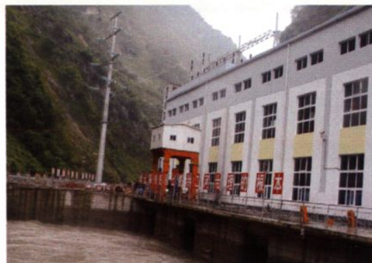
装机12.6万千瓦的大金坪电站
