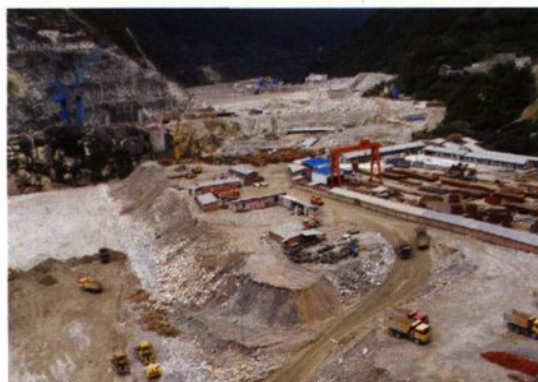
装机70万千瓦的龙头石电站施工现场
