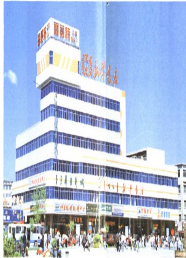
市级样板工程新华书店营业楼
