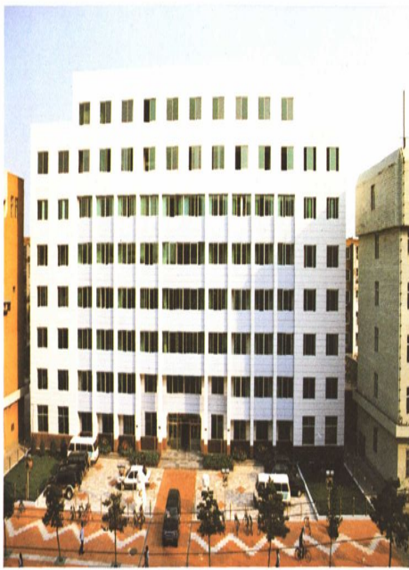
赤峰市建设局大楼
