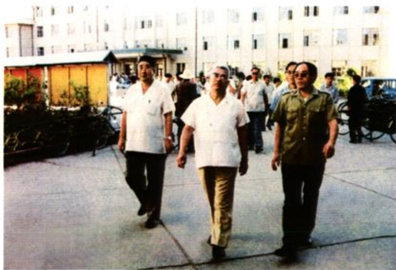
1990年7月18日， 自治区党委书记黄璜 (中)视察石嘴山矿三号 立井工地。
