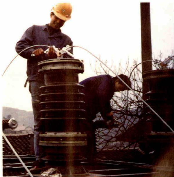
△电力公司工人检修高压设备
