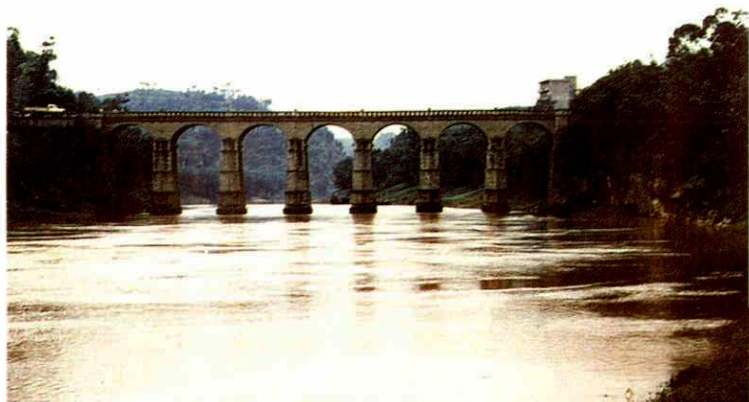
△成渝公路球溪河大桥
