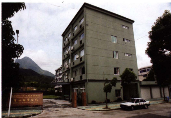
管理处综合楼
