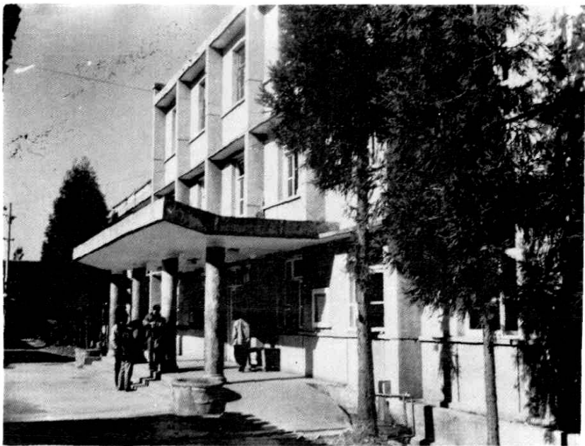
美姑县人民医院住院部
