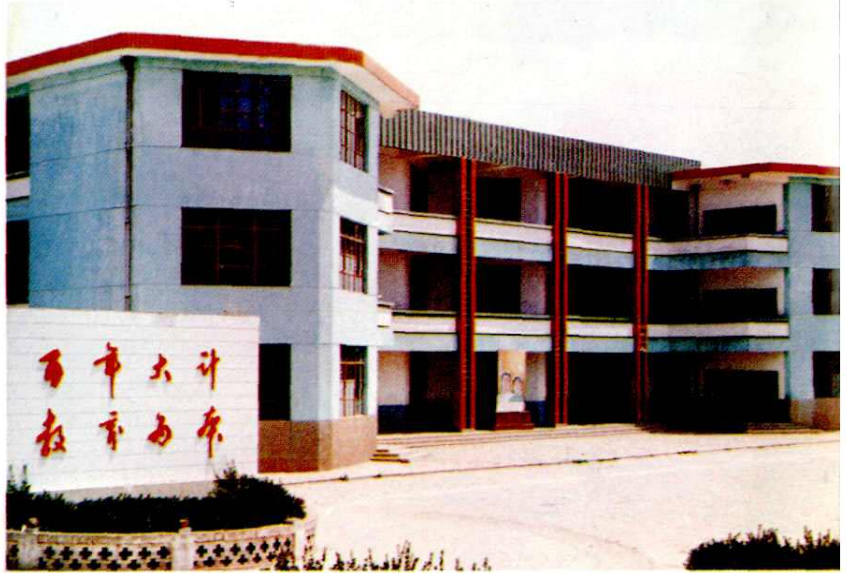
路井镇中学教学楼
