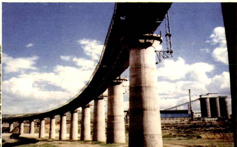
鹤儿山矿集运站铁路大桥
