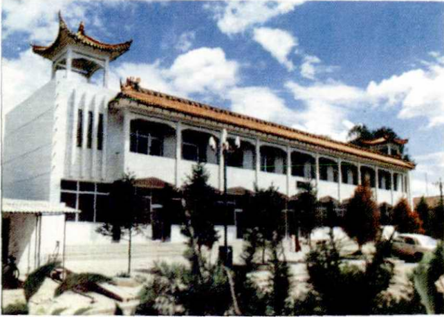
煤炭运销公司办公楼
