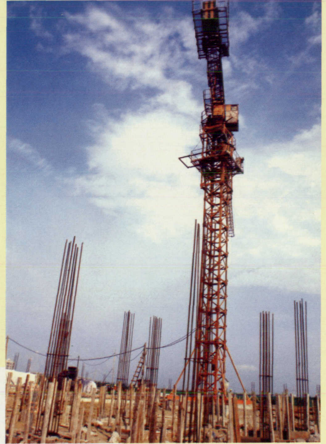
▲ 变电站土建施工
