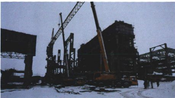
建设中的炼钢车间
