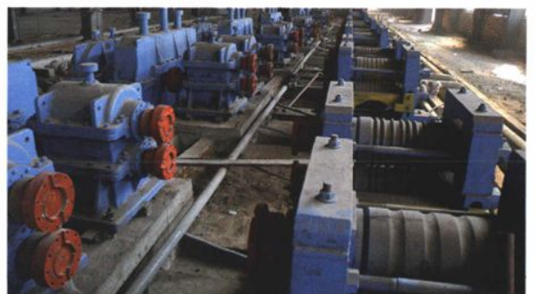
轧钢车间设备安装
