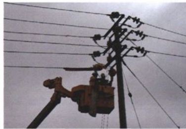
公司使用带电作业车抢修线路
