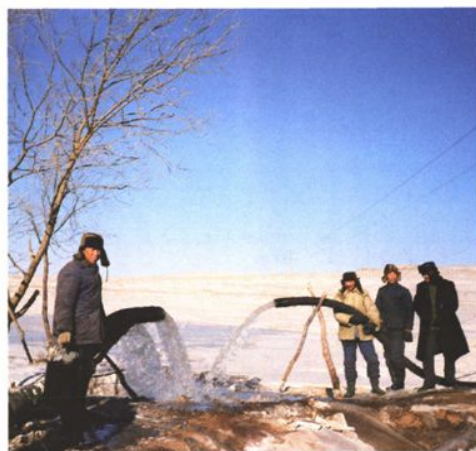
人工打成的第一口大井出水
