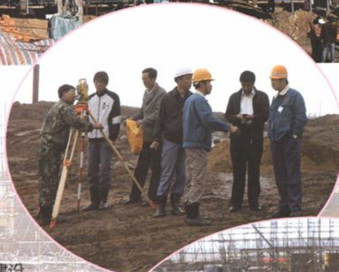
3号高炉开工测量
