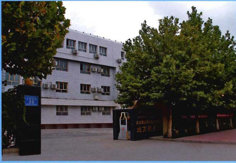
克州地税局机关办公大楼
