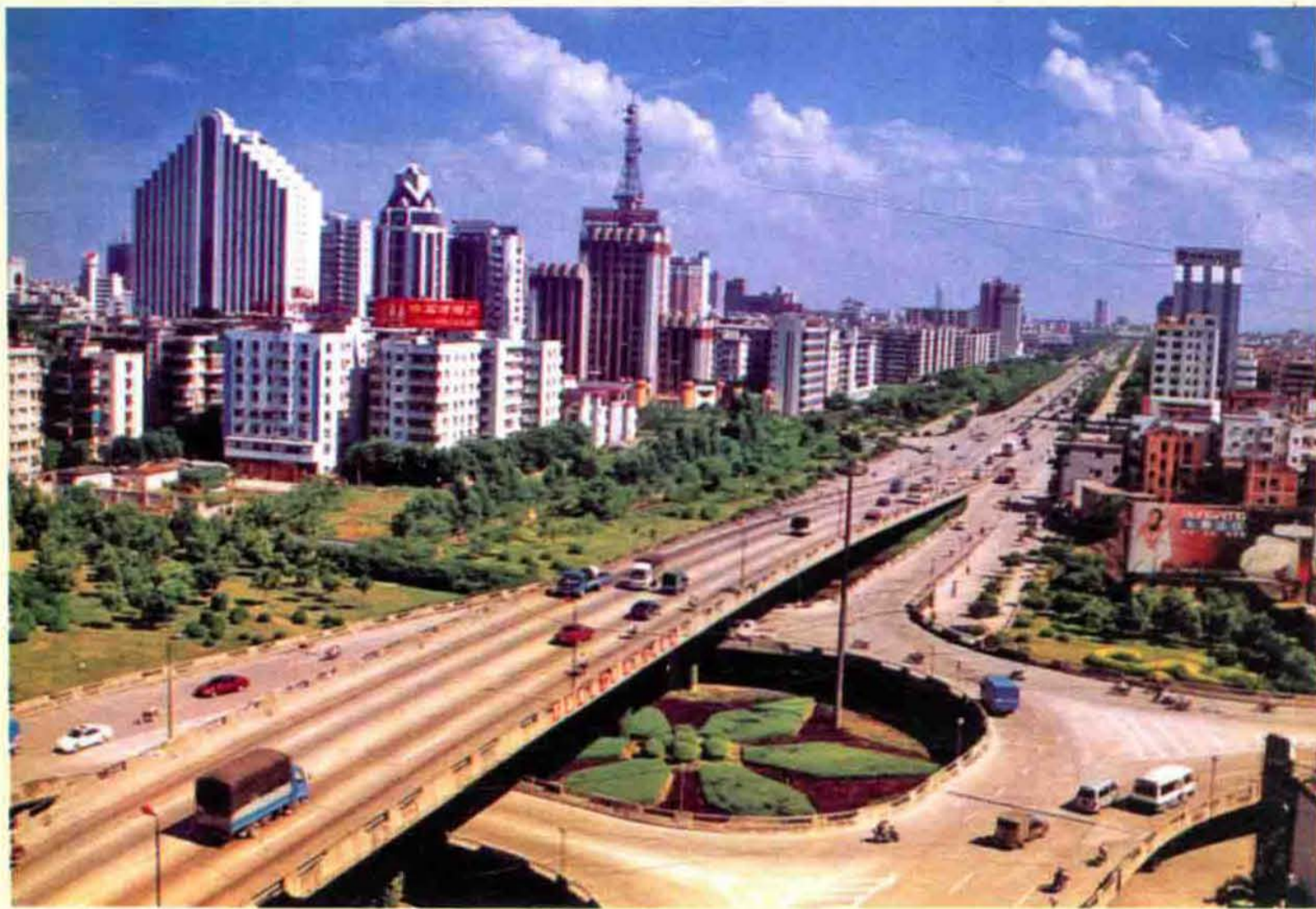
325国道佛山大道段的江湾立交桥（1995年）
