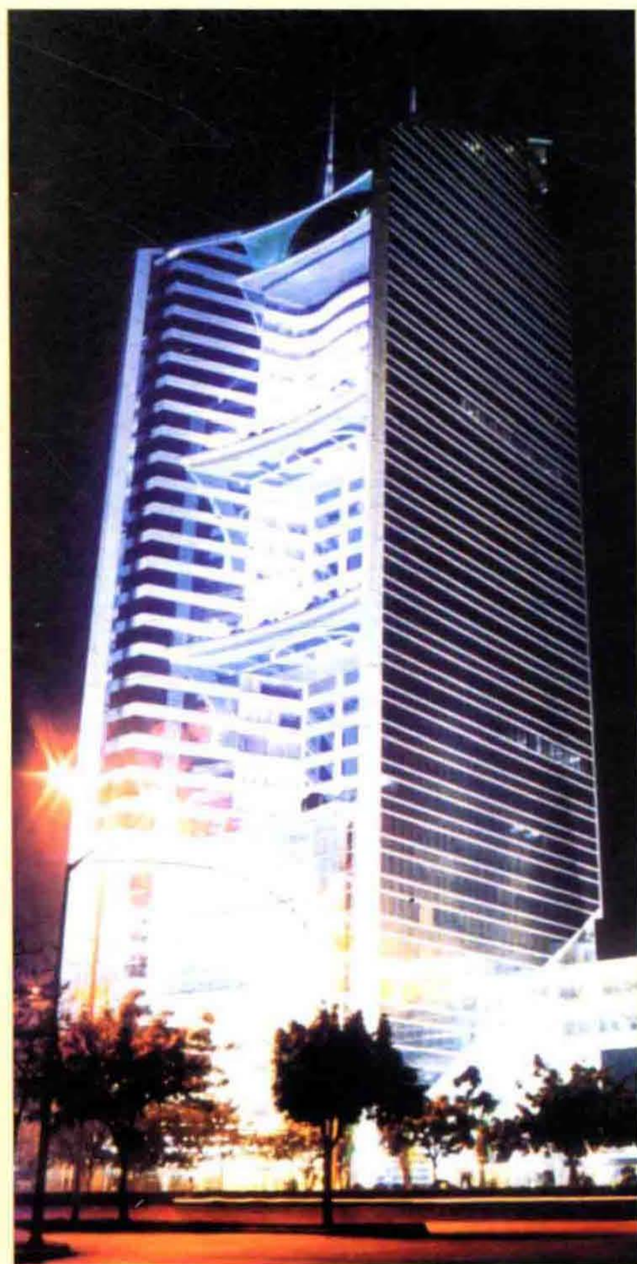
位于汾江南路的佛山供电局 新电力调度大楼（2002年）
