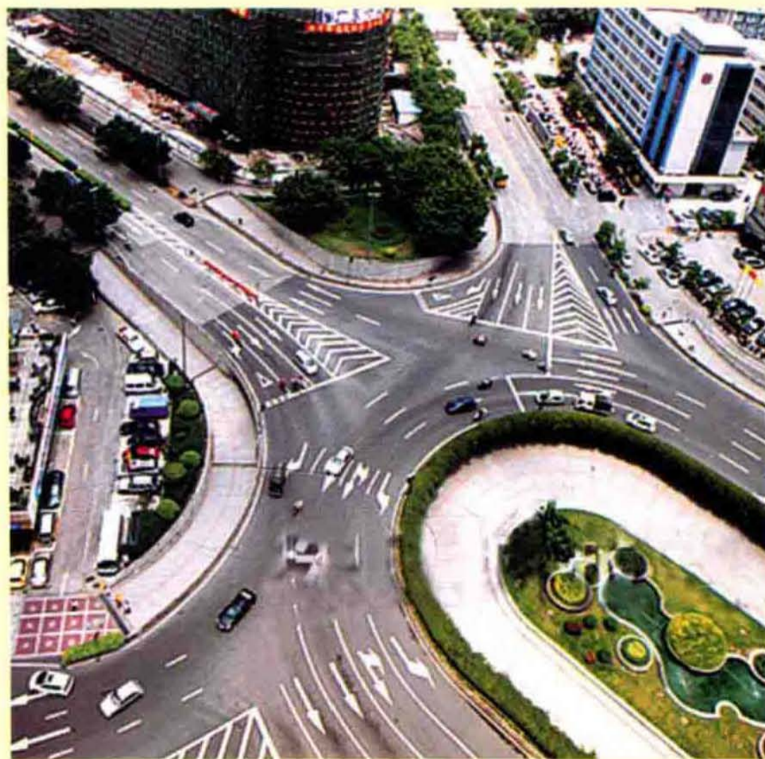
改造后的汾江路城头广场 (2002年)
