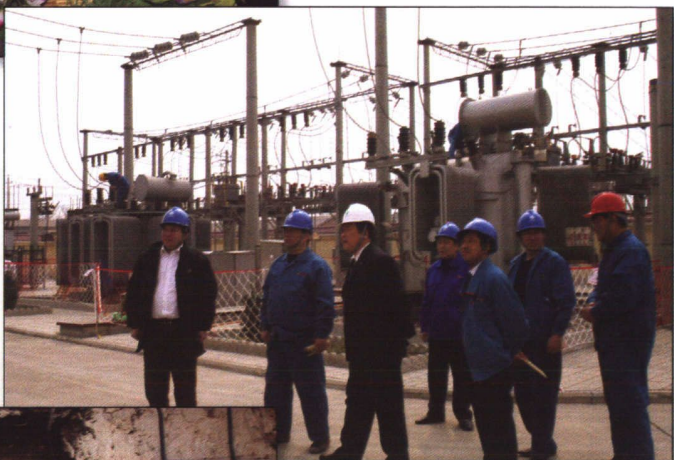
2007年3月12日，运城供电分公司工会主席尚凯（左三）到芮城供电支公司春检现场检查工作
