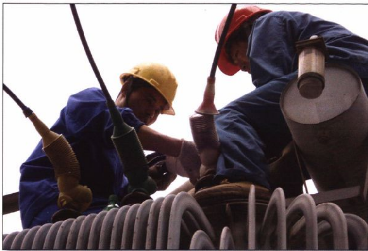
有条不紊的电力抢修现场
