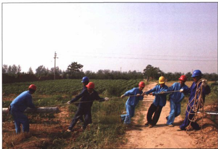
暴风雨过后，供电施工人员在抢修损坏的杆塔
