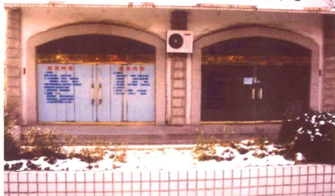
合肥市妇幼保健所高新区分所
