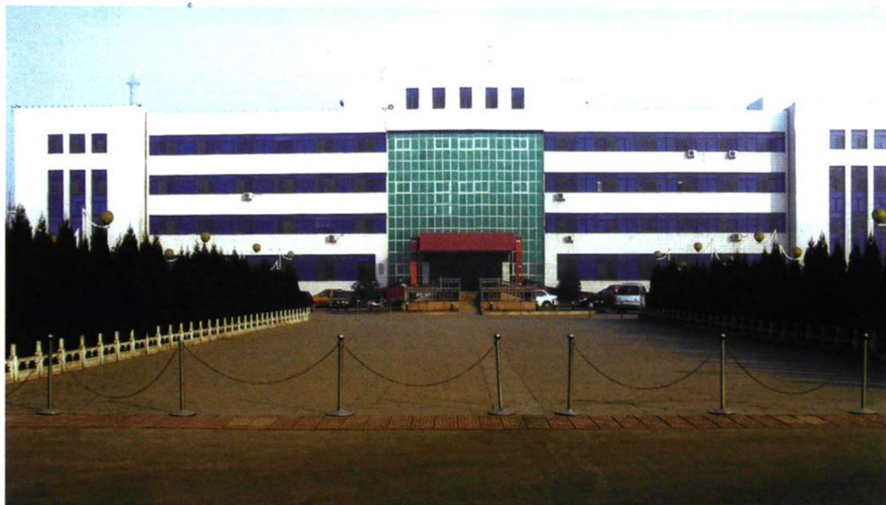
■ 襄汾县人大常委会办公大楼
