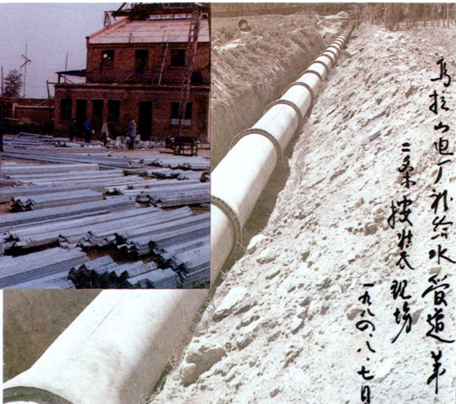
预应力混凝土管道安装
