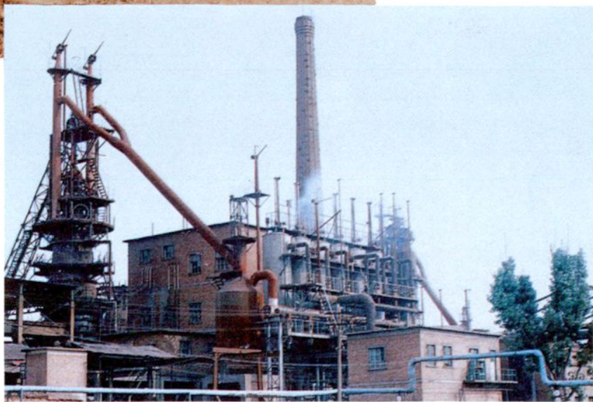
包头东风钢铁厂新建高炉外景
