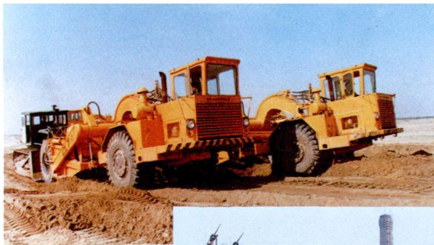
平整场地作业
