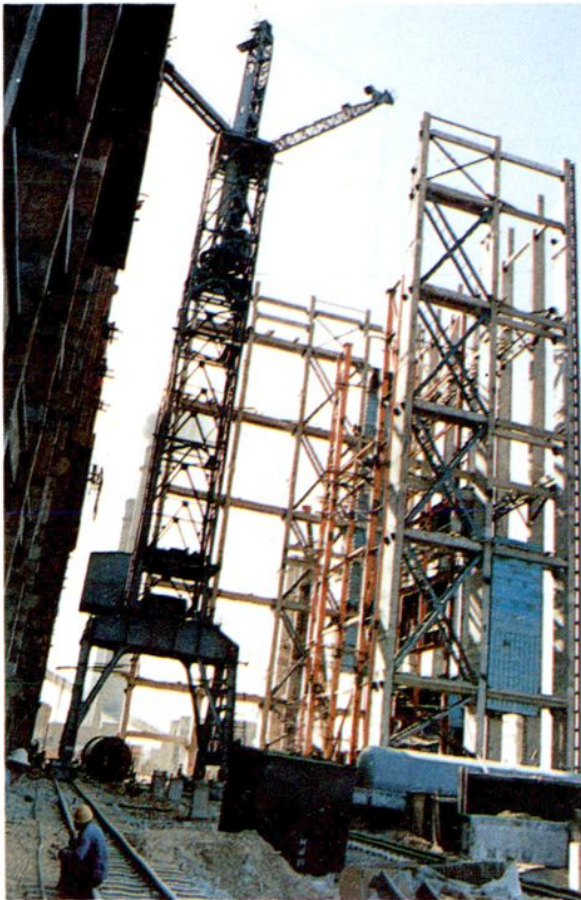
自制 50 吨塔吊进行 410 吨/时锅炉钢架 吊装作业
