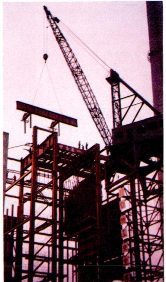
锅炉钢架吊装作业
