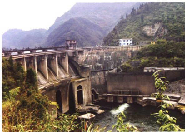
图22 1993年7月，角口水电站竣工投产
