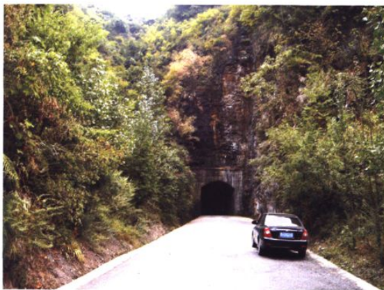
图26 1992年,抄乐至石莲公路竣工,图为解乐村与黄莲村交界处的水落洞隧道
