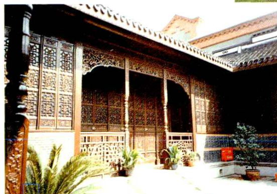
浦东新区陆家嘴路160弄 住宅内景
