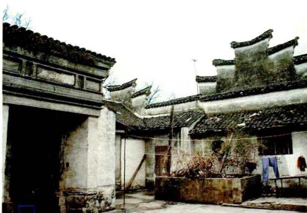
松江县中山西路明代民宅
