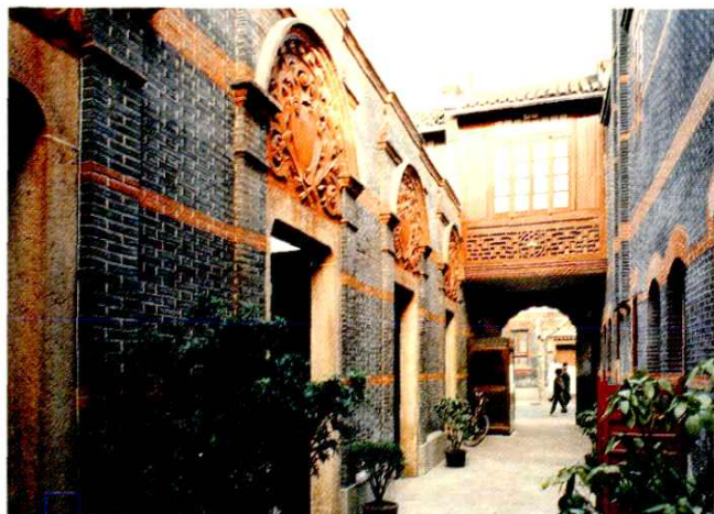
兴 业路 80 弄石库门里弄住宅 树德北里
