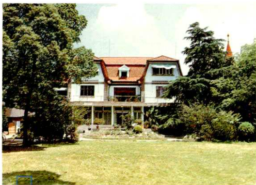
岳阳路 145 号荷兰式花园住宅
