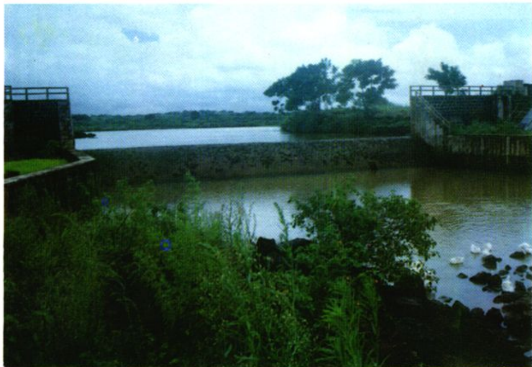
松涛水库灌区桥头坝工程。
