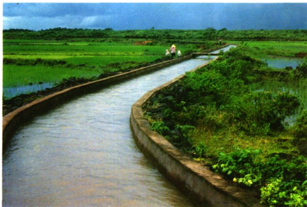
桥头坝右引水渠。
