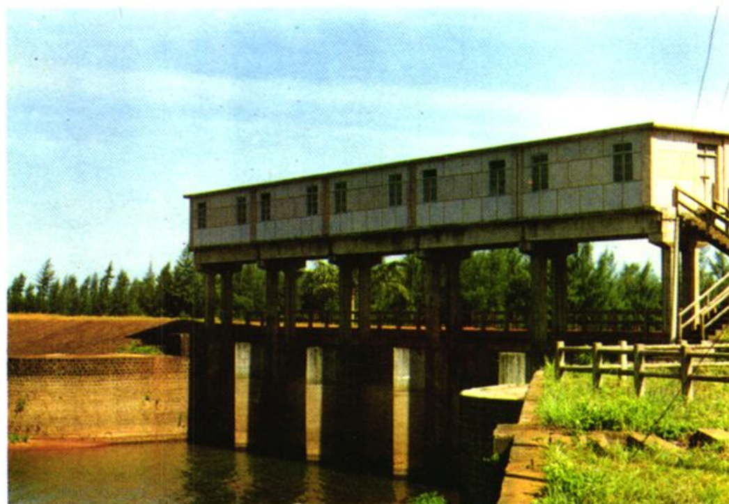
凤潭水库（中型）溢洪道平板闸门。
