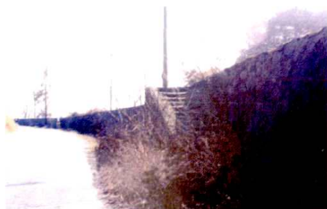
杨墩头自然村前护村堤
