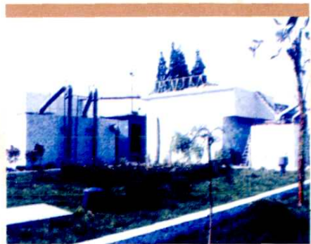
埭溪水厂(日供水8000吨)
