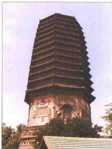
图9 天宁寺塔 北京城区仅存的辽代建筑。密檐八角十三层，通高58.7米。在整体造型和局部手法上表现了辽代密檐砖塔的建筑风格，是研究中国古代佛塔的重要实例。同时该塔又是研究辽南京城址地理位置的重要依据。
