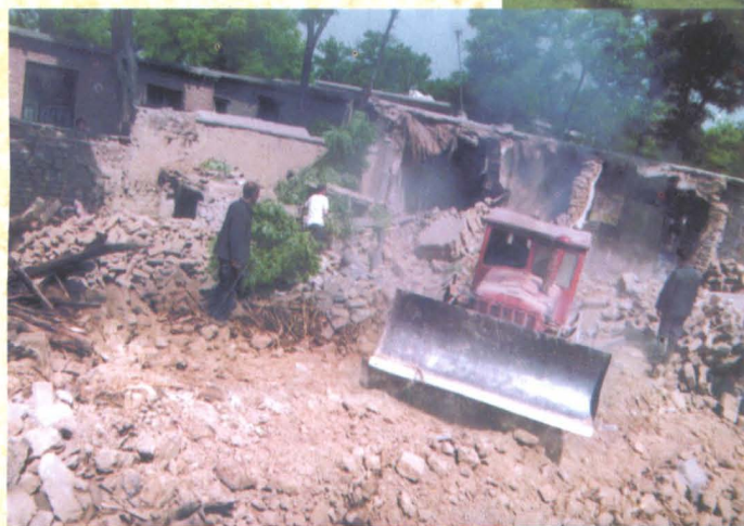
拆除违法占地建筑物
