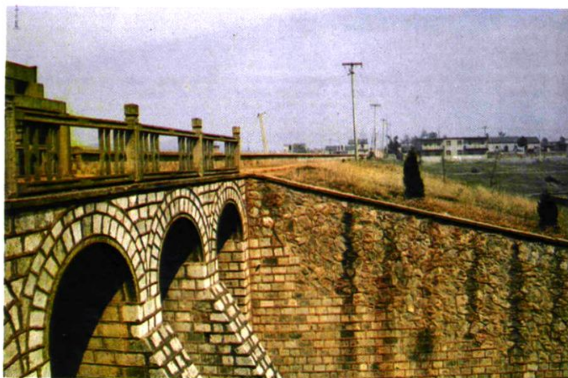
△潭山水库一角
