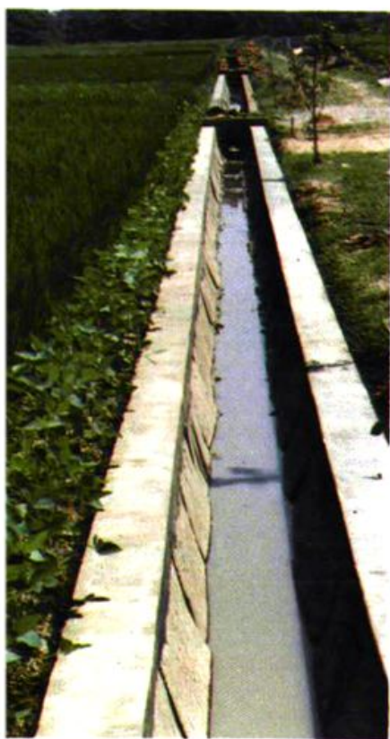
△中低产田改造李岗头村配置水泥预制的U形渠系列之一
