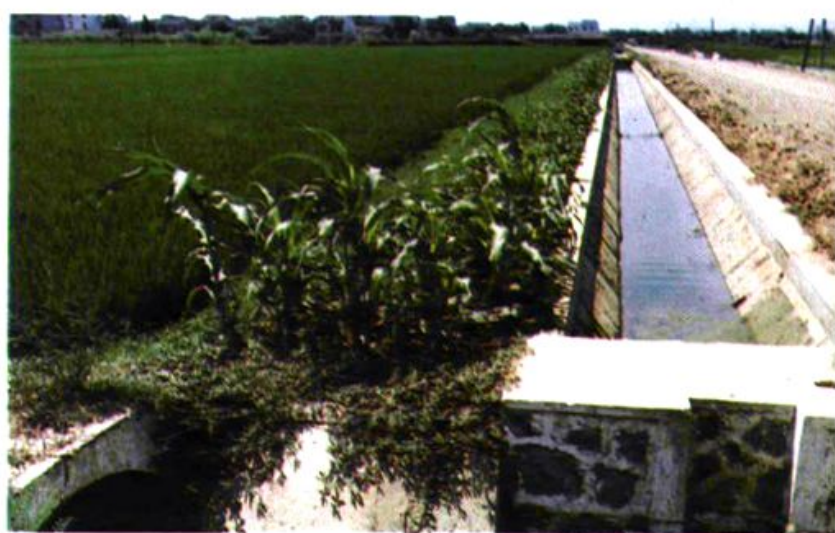
△中低产田改造上峰村配置水泥预制的板渠系列之一
