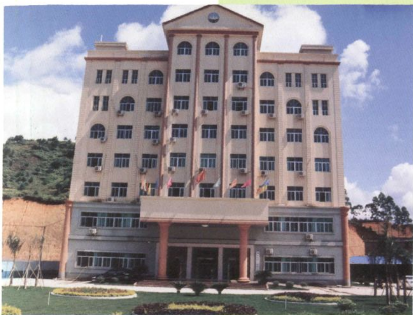
位于县城城南路的浦北县国土资源局办公楼外景。
