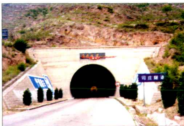
208国道武乡司庄隧道
