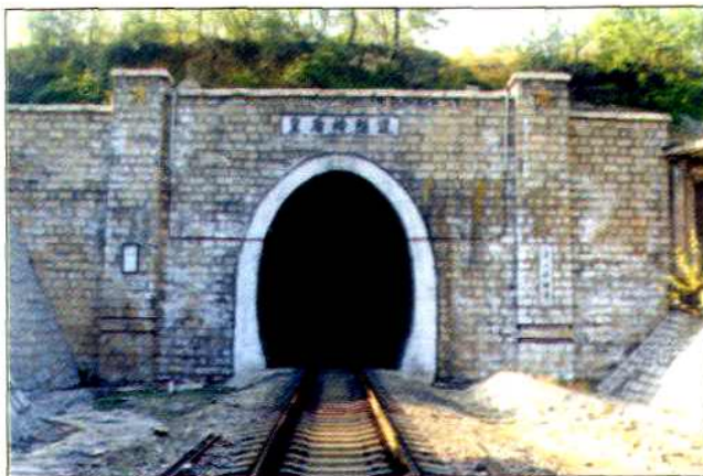
邯长铁路黎城皇后岭隧道
