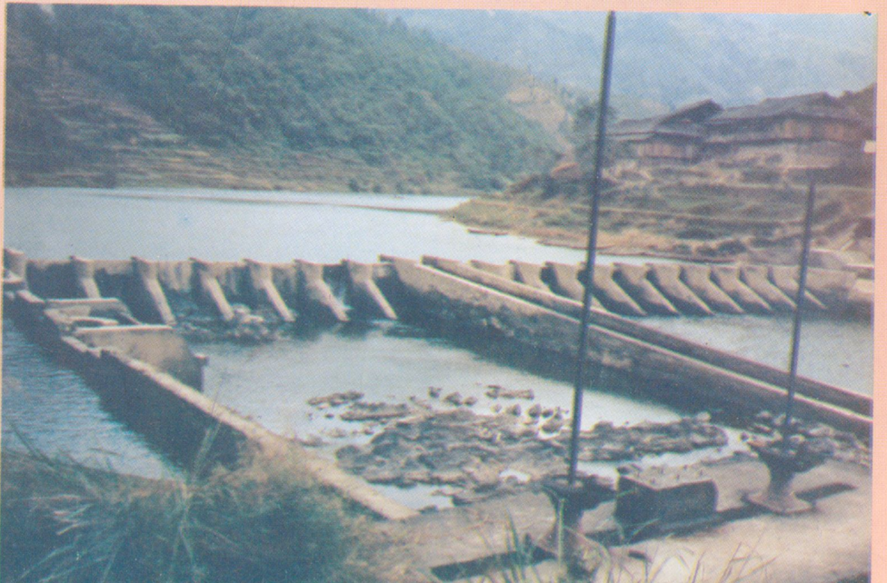
孟化水电站坝首
