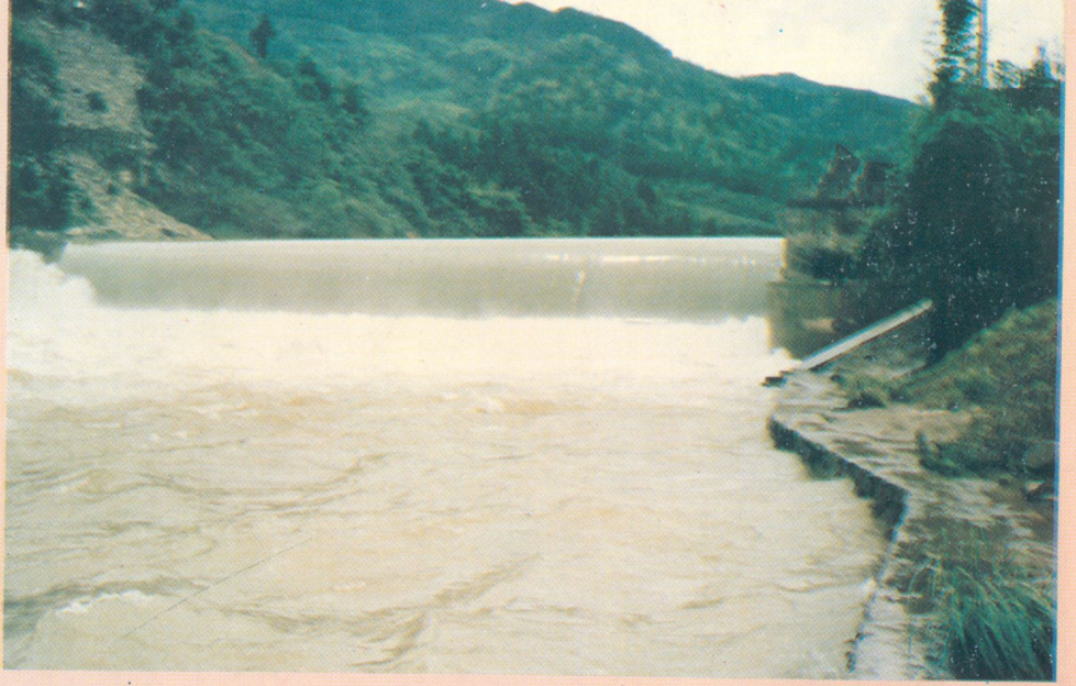
大滩水电站坝首
