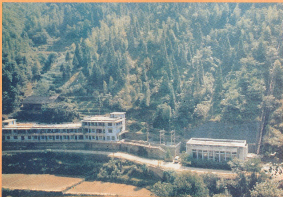
白石水电站全景
