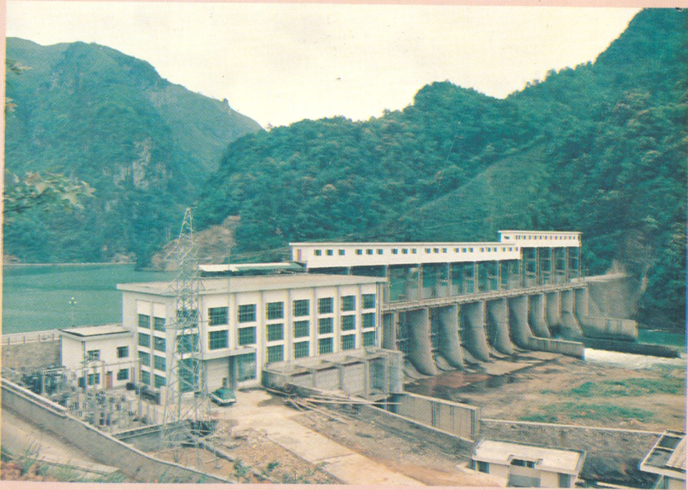
勒黄水电站坝首、厂房、升压站
