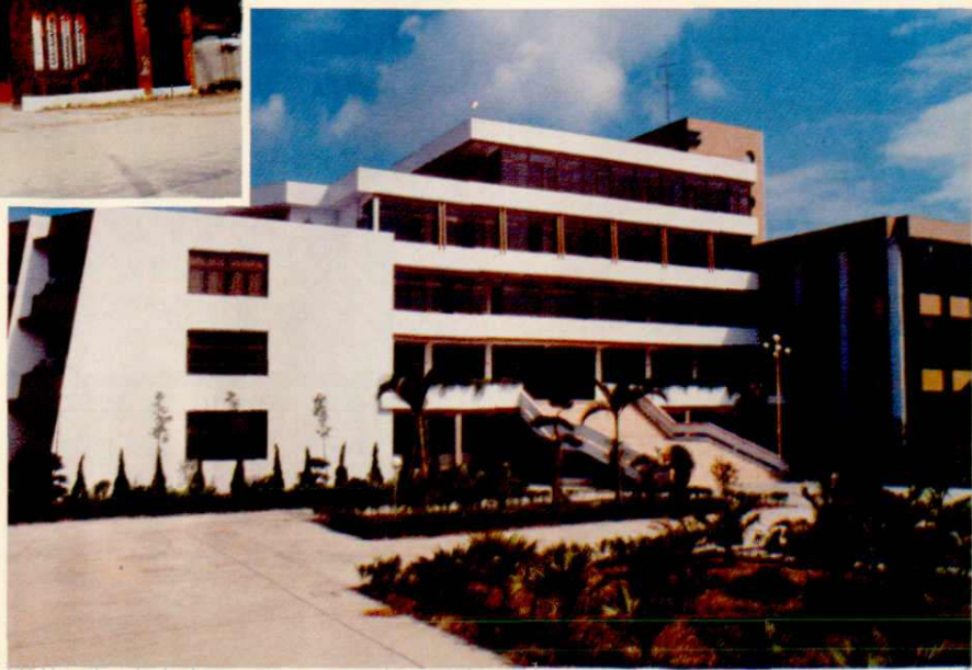
镇政府办公大楼▷ (上大门、右主楼)
