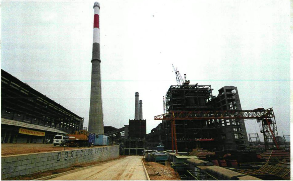
建设中的410吨/小时循环流化床锅炉工程
