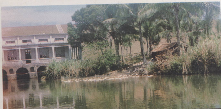
军田水库坝后水电站
