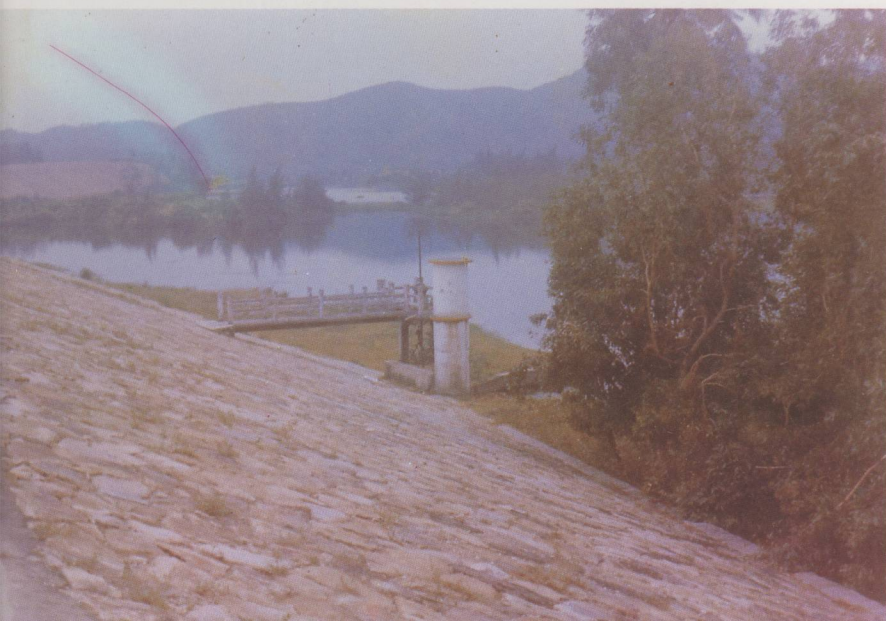
加坦水库主坝
