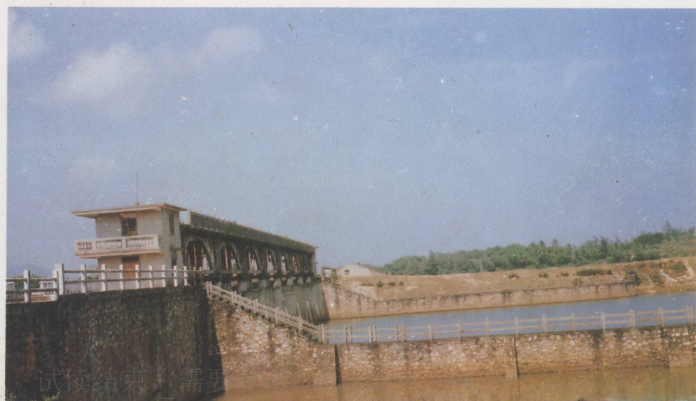
龙滚河分洪桥闸
