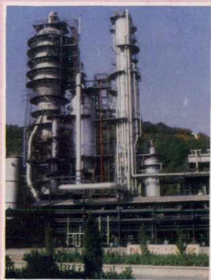
兰州石油化工机器厂为荆门炼油厂生产的催化裂化装置
