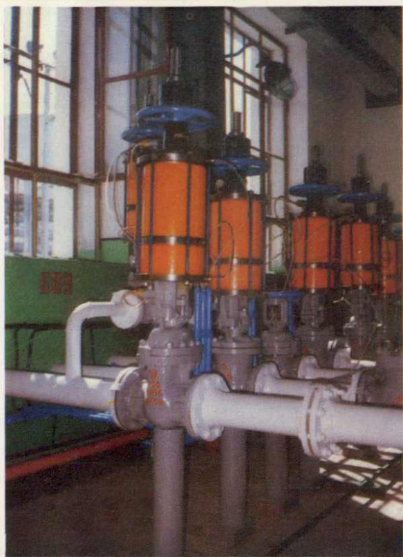
兰州高压阀门厂双缸气动闸阀
