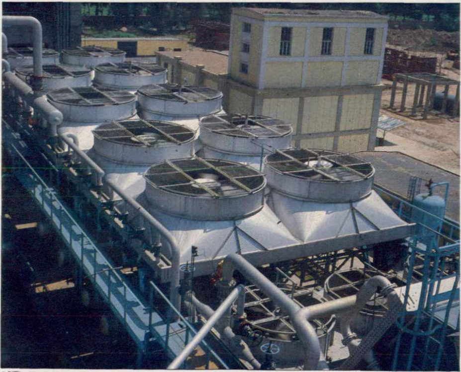
兰州长征机械厂空气冷却器在炼油装置中运行
