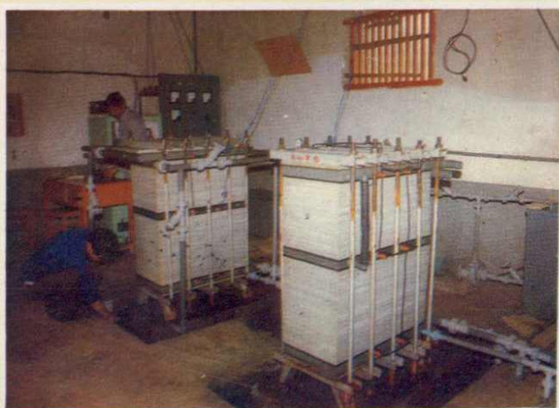
甘肃省电影机械厂苦咸水淡化装置—电渗析器
