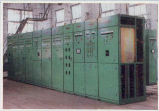
天水长城控制电器厂GCK/GCL低压抽屉式开关柜
