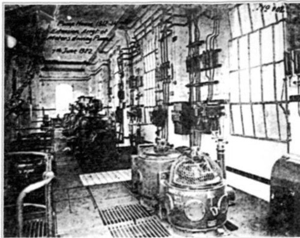
民国元年(1912年)至民国3年(1914年)电站 循泵房内景
