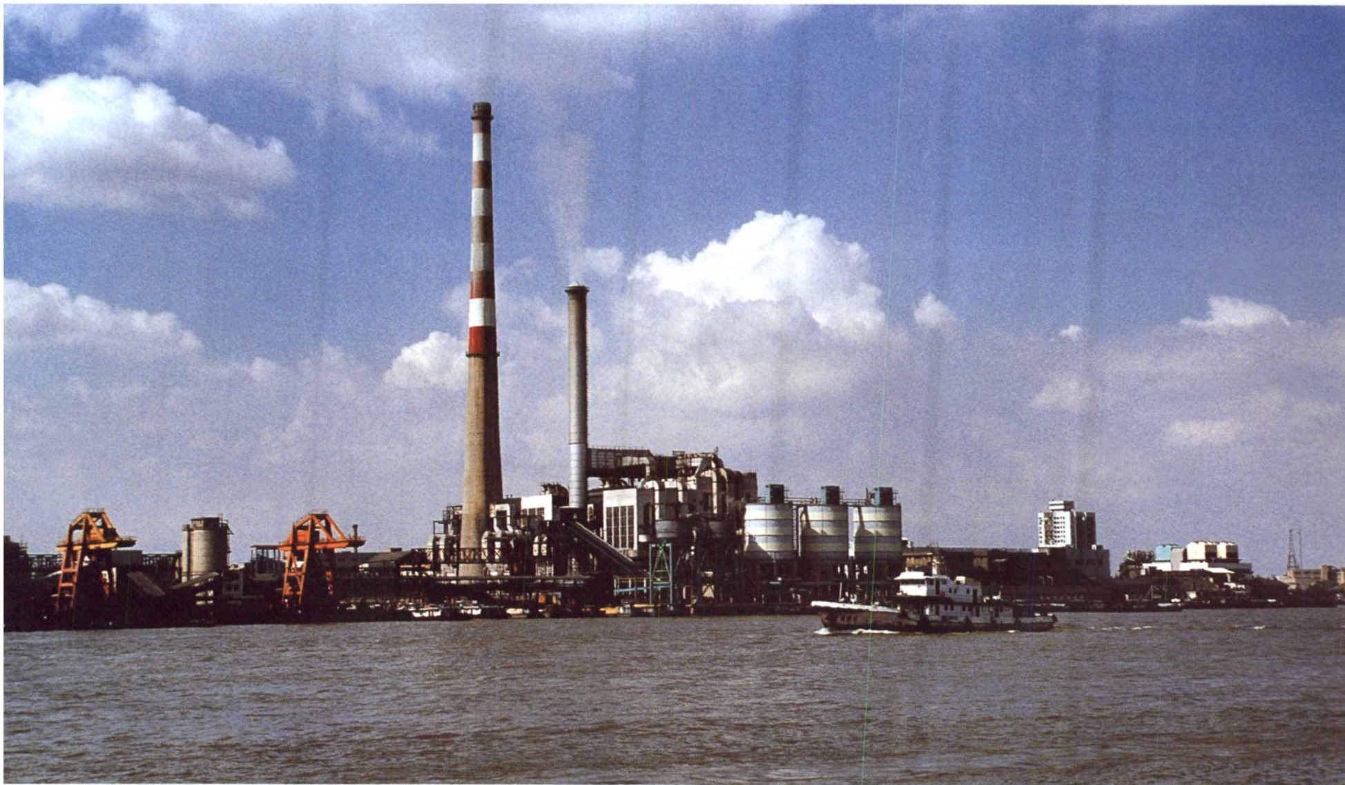
1990年上海杨树浦发电厂全貌
