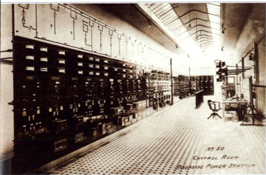
民国13年(1924年)建成的江边电站控制室
