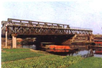
中槎浦铁路桥
