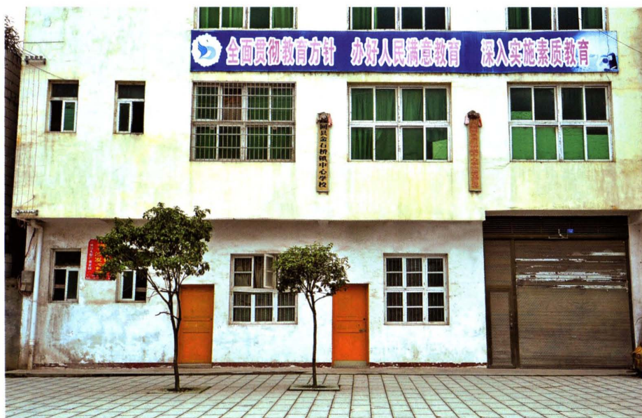
镇中心校办公楼
