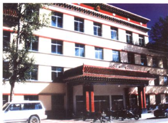
政府办公大楼
